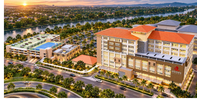
Hospital Putrajaya, Wilayah Persekutuan
